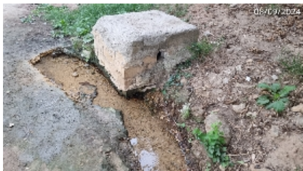
Manantial de Las Aceñas, arqueta rebosadero sellada (A. Ventas, septiembre 2024)
