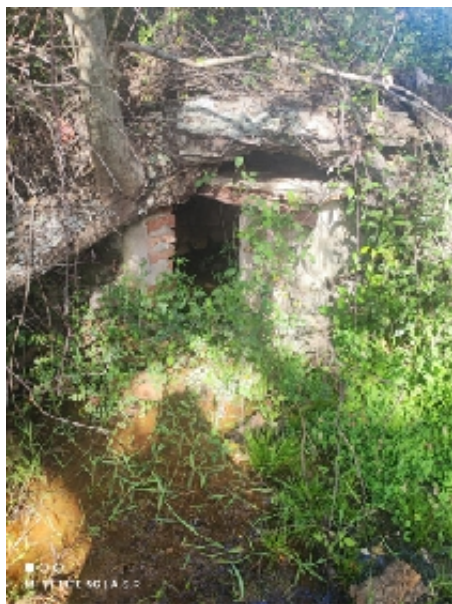
Fuente Las Casillas (A. Sánchez Román, abril 2024)
