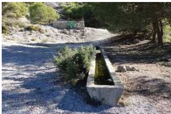
Abrevadero y aljibe de Los Albatrales (M. Limón Andamoyo, noviembre 2023)
