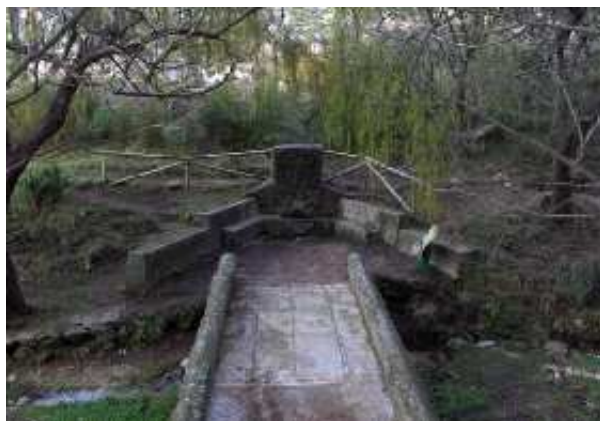
Fuente del Descansadero (S. Rodríguez Domínguez, diciembre 2011)
