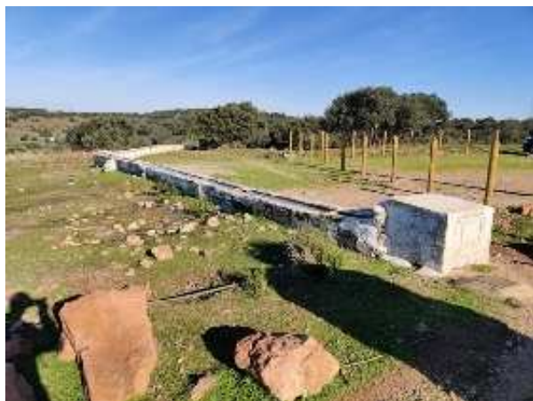
Vista del pilar abrevadero de Burguillos (D. Sánchez Garrido, diciembre 2020)
