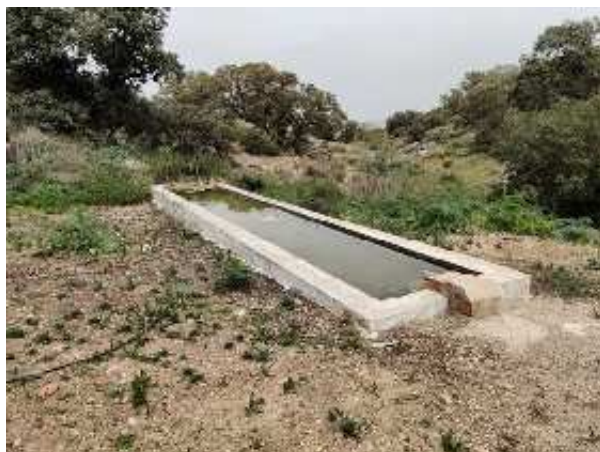
Vista de la Fuente de la Loma de la Tableta (D. Sánchez Garrido, marzo 2021)
