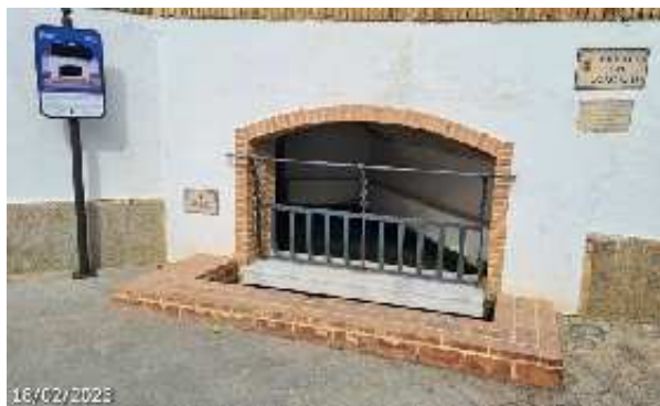
Fuente del Concejo, aspecto actual (A. Ventas, febrero 2023)
