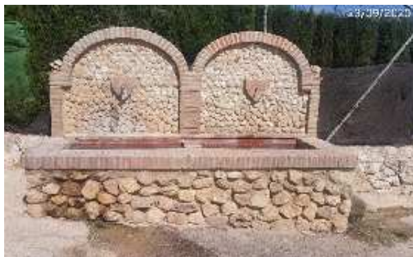
Fuente, aspecto actual, vista frontalmente (A. Ventas, septiembre 2020)
