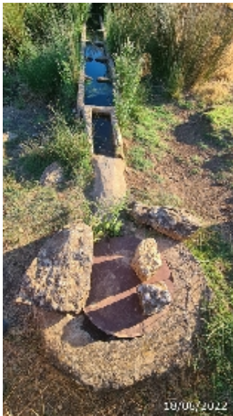
Vista general de la fuente y pilas de Almellones (A. Ventas, agosto 2022)
