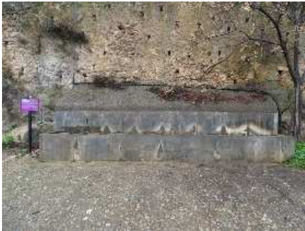
Vista del lavadero (J. F. Martín Álvarez, enero 2023)
