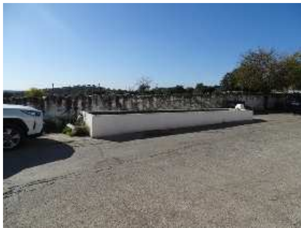
Vista general del pilar (J. F. Martín Álvarez, noviembre 2022)
