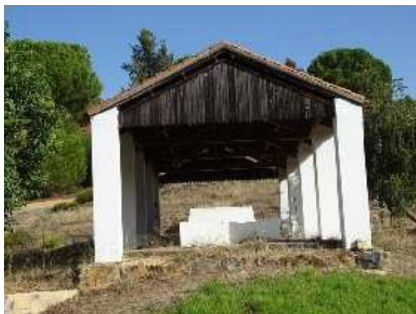
Vista general del lavadero (J. F. Martín Álvarez, octubre 2022)
