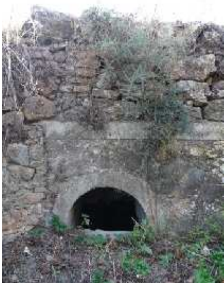
Vista general de la fuente (J. F. Martín Álvarez, octubre 2022)
