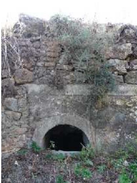
Vista general de la fuente (J. F. Martín Álvarez, octubre 2022)
