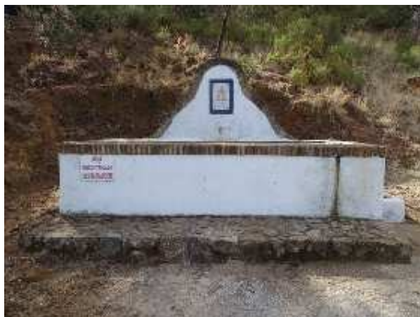
Vista general del pilar (J. F. Martín Álvarez, septiembre 2022)
