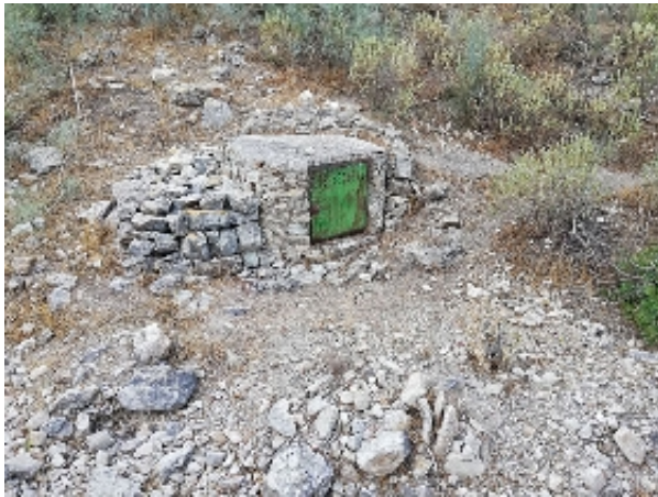
Alcubilla que protege al manantial y al pozo de captación (P. Sánchez Gil, septiembre 2022)
