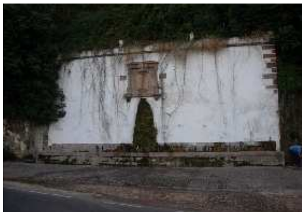
Pilar de las Herrerías (J. M. Medina, septiembre 2006)
