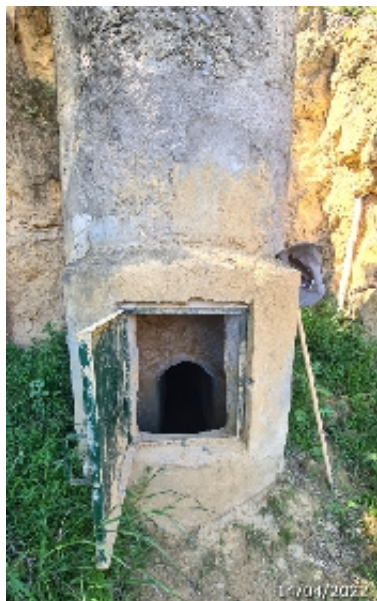
Boca de la galería, abierta, en la parte inferior de la última lumbrera (A. Ventas, abril 2022)
