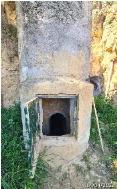
Boca de la galería, abierta, en la parte inferior de la última lumbrera (A. Ventas, abril 2022)
