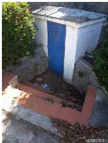
Bajada a la casetilla del manantial, cerrada (A. Ventas, mayo 2021)
