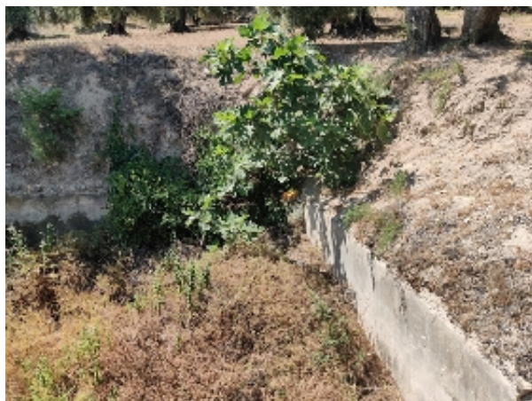
Detalle de la esquina de la alberca donde se encuentra el caño (D. Sánchez Garrido, junio 2021)
