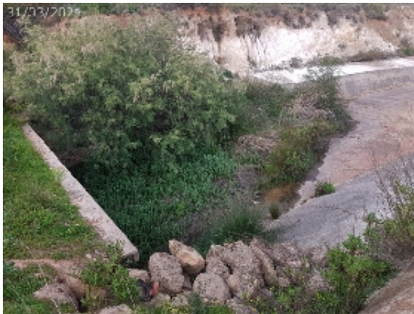
Salida de las aguas del manantial al canal (A. Ventas, marzo 2021)
