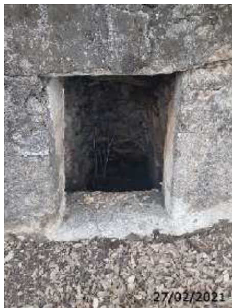
Acceso exterior de la fuente (A. Ventas, febrero 2021)
