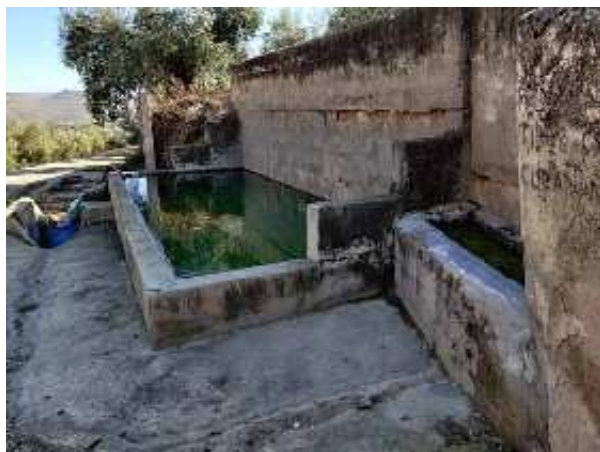
Pilar de los Arroyos, en el Camino de Cárchel a Jaén (D. Sánchez Garrido, enero 2021)
