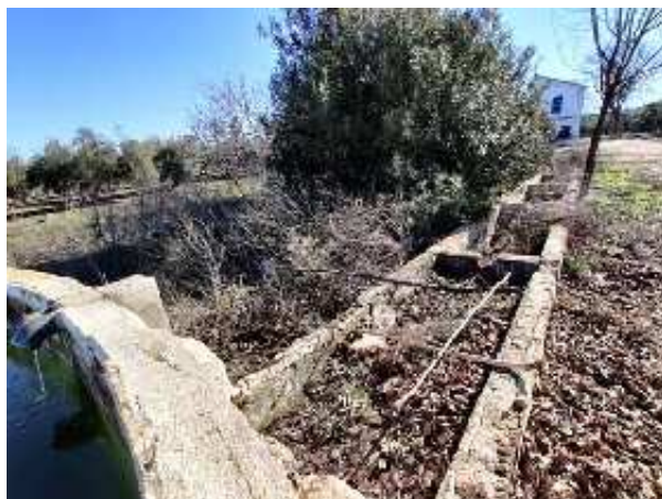
Pilas de las Banderas, junto a la alberca (D. Sánchez Garrido, enero 2021)
