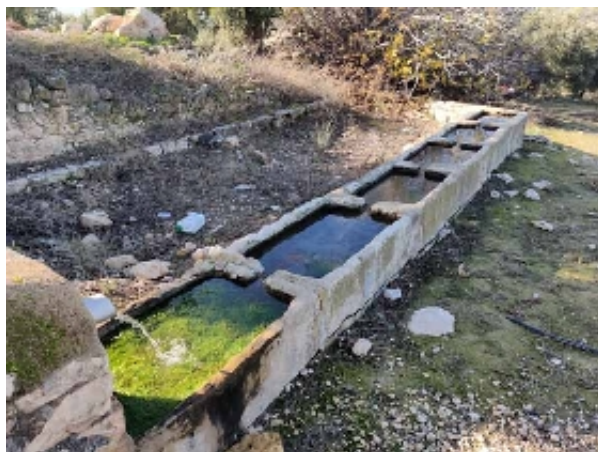
Vista general de las Pilas del Espeso. (D. Sánchez Garrido, diciembre 2020)
