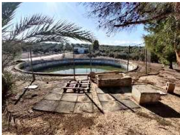
Vista general de la alberca de Madrigueras (D. Sánchez Garrido, diciembre 2020)
