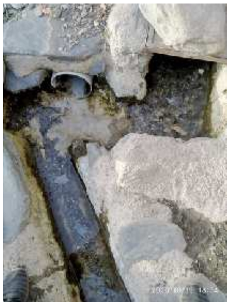
Salida del agua por el canalón en La Zanja, junto a una arqueta de captación (E. Archilla, octubre 2020)
