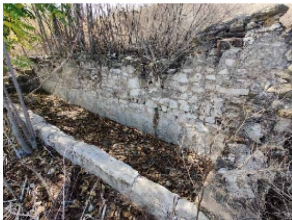
Vista del Pilar de Macarena (D. Sánchez Garrido, noviembre 2020)
