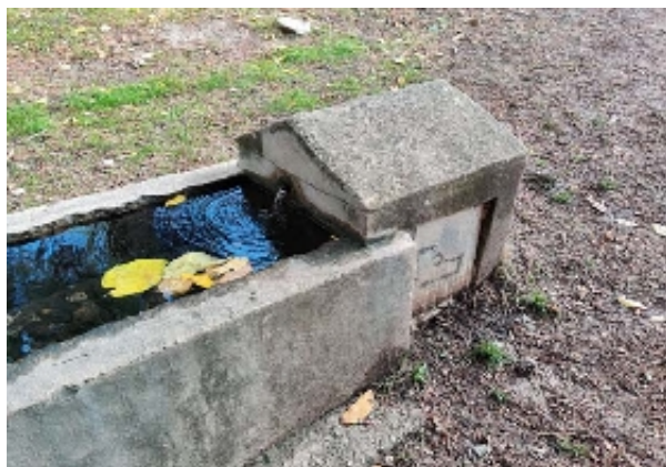
Detalle del caño de agua del Pilar de los Pastores (D. Sánchez Garrido, noviembre 2020)
