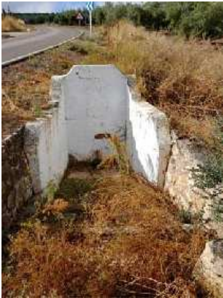
Vista general de la Fuente del Zurro (D. Sánchez Garrido, octubre 2020)
