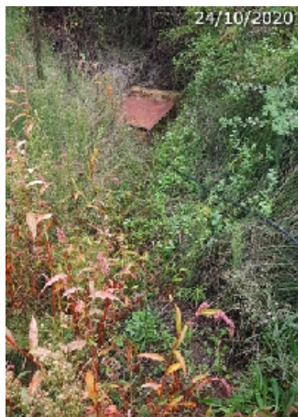
Captación para las casas del manantial (A. Ventas, octubre 2020)
