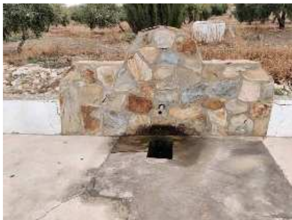
Vista general de la fuente de la Pajilla (D. Sánchez Garrido, octubre 2020)
