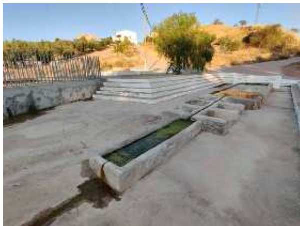
Pilar de Torrequebradilla (D. Sánchez Garrido, octubre 2020)
