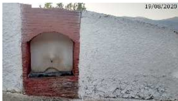
Fuente del Tomate, en el muro de la calle (A. Ventas, agosto 2020)
