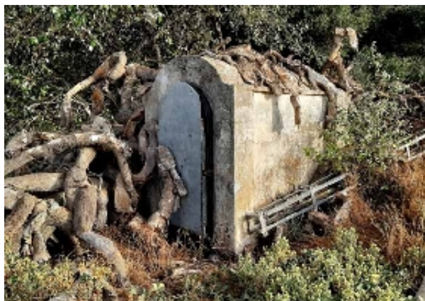
Casilla de acceso a la galería (J. M. Amarillo, julio 2020)
