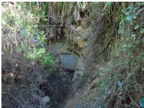
Mina de la Casa de la Solana (M. Limón Andamoyo, marzo 2019)
