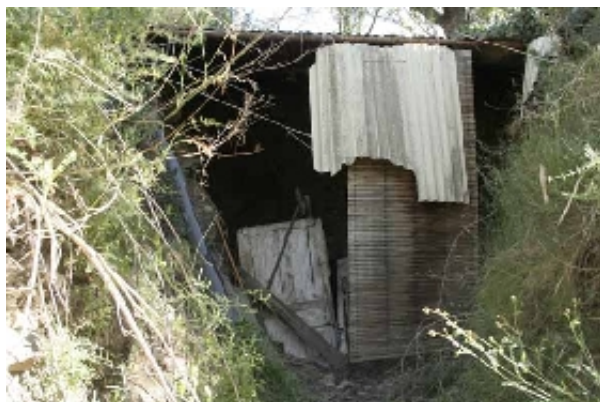
Mina del Lagar de Mariblanca (A. Vela Torres, marzo 2019)
