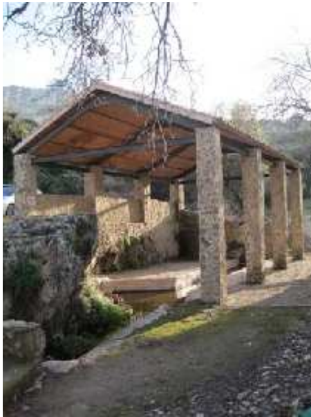
Nacimiento del Lavadero, cubierta (F. Aguilera Civantos, marzo 2020)
