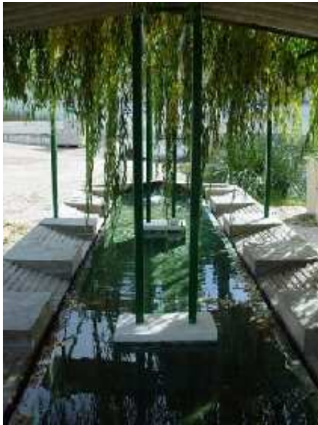
Lavadero de Los Tubos (C. Herrera, noviembre 2005)
