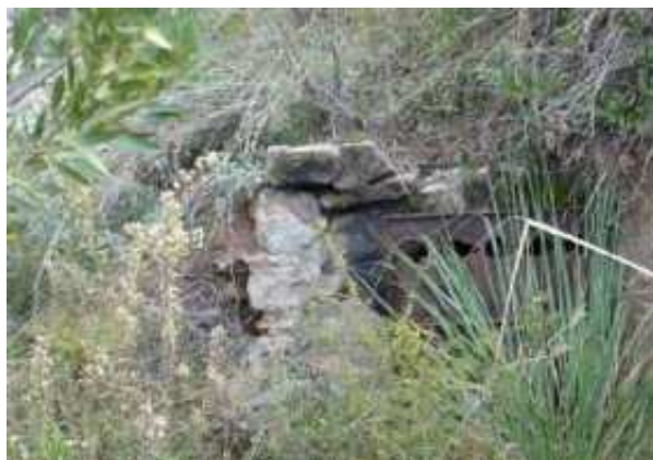
Fuente de Pisnela - Galería (J. Martín, noviembre 2008)
