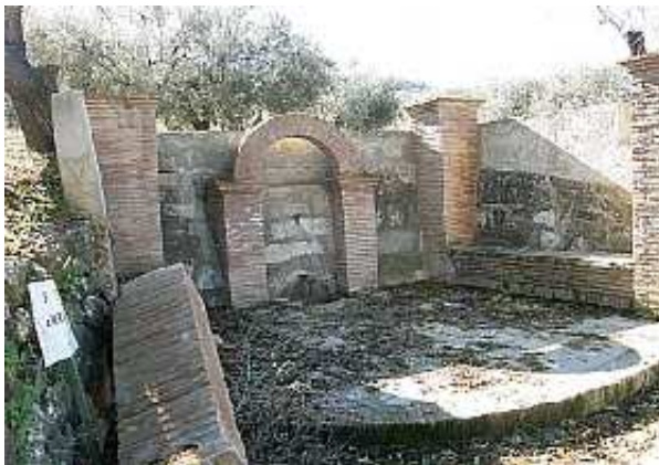
Fuente del Caño (A. Vela Torres, noviembre 2008)
