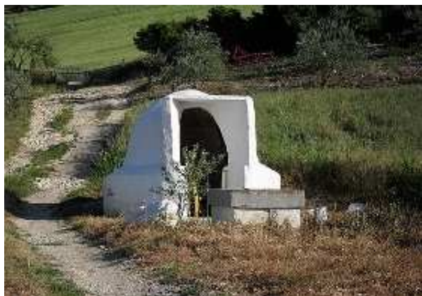
Pozo del Gallardero ( www.caminoabierto.org , 2011)
