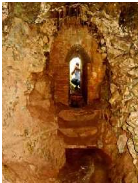
La bajada de escalones y embalse con el desagüe a la derecha (foto A.M.)
