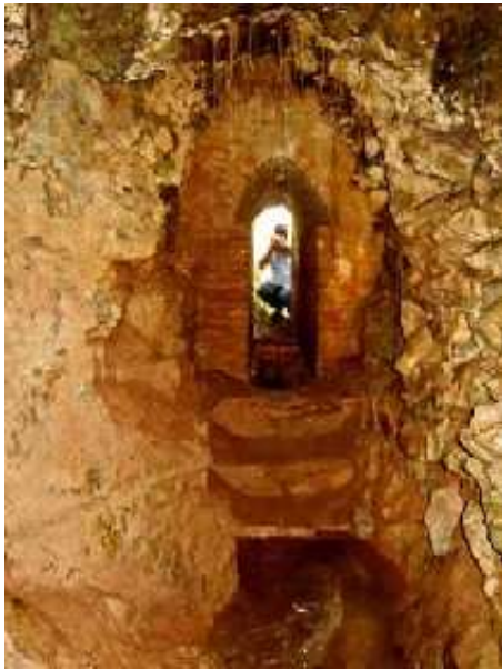
La bajada de escalones y embalse con el desagüe a la derecha (foto A.M.)
