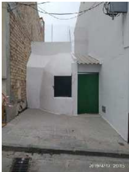
Pozo de la calle Fuente Alta (D. Rodríguez Sancho, abril 2019)
