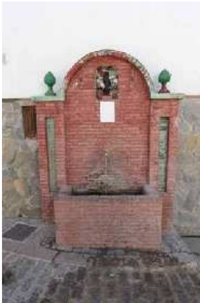
Pilar de la calle Agua (M. Limón Andamoyo, abril 2019)
