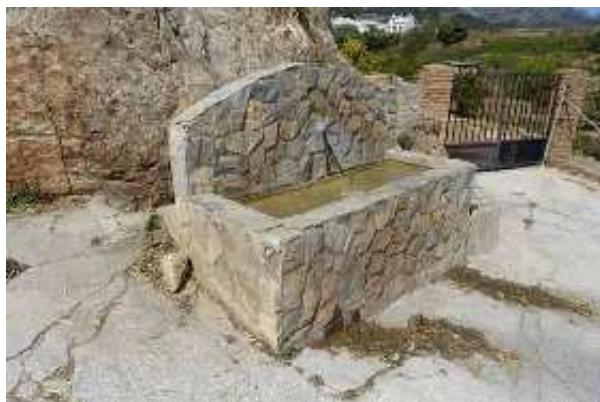
Abrevadero de la Teja M. Limón Andamoyo, (abril 2019)
