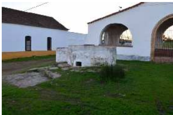
Pozo del Matadero (M. Mora Tenorio, diciembre 2018)
