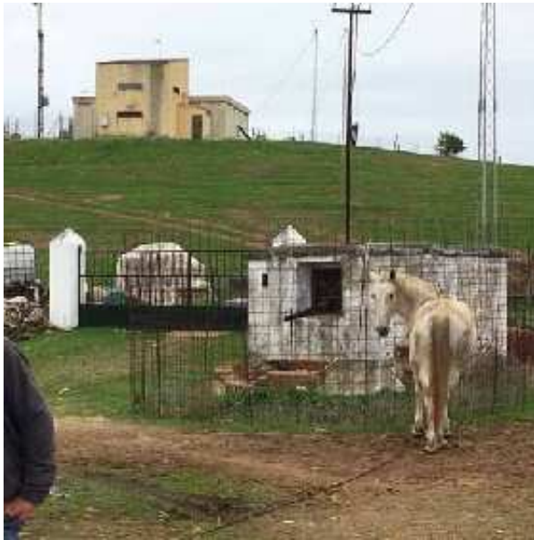
La cañada, al fondo junto a la acémila, las casetas de bombeo con el pozo nuevo y, al lado, uno de los pozos originales (J. M. Fernández-Palacios, noviembre 2018)
