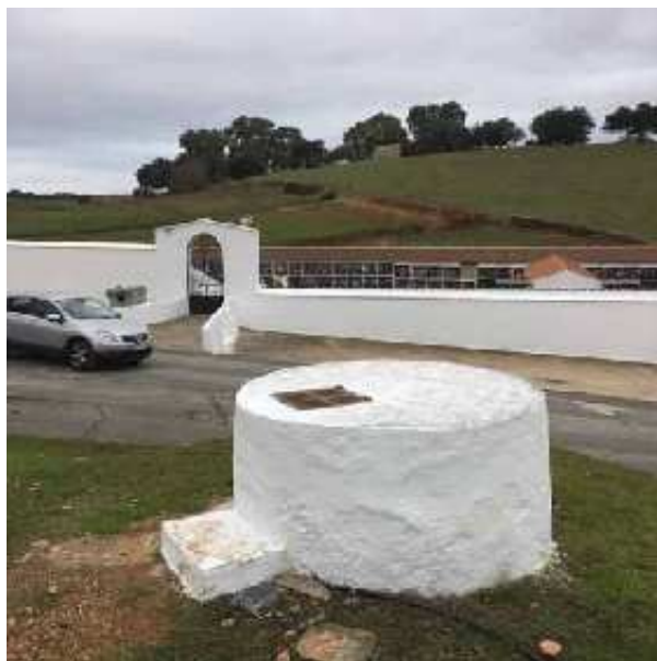
Pozo del Cementerio (J. M. Fernández-Palacios, noviembre 2018)
