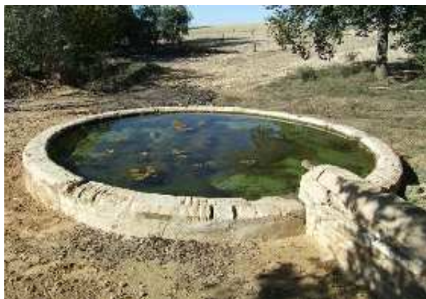
Detalle de la Fuente de Pradomedel y desagüe (F. Cuesta, noviembre 2008)
