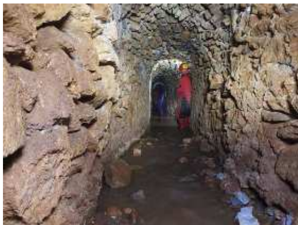
Galería del Cabezo de la Jara, interior (A. González Ramón, septiembre 2018)
